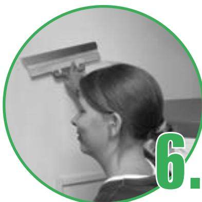
CaSi-Systems Wohnklimaplatten-Kleber 3in1 auf die Oberfläche aufziehen und die CaSi-Systems Gewebematte einbetten. Anschließend die gesamte Fläche abspachteln und glätten. Nach der Trocknungszeit können Sie mit der diffusionsoffenen Oberflächengestaltung, z.B. mit der CaSi-Systems Silikatinnenfarbe, beginnen.
