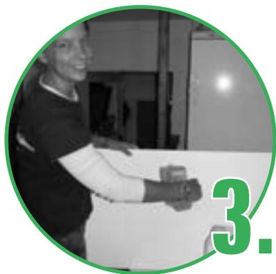
Auftragen der CaSi-Systems Silikatgrundierung, z.B. mit einem Quast oder einer Druckspritze, auf die CaSi-Systems Wohnklimaplatte Premium Vor- und Rückseite. Vor dem Verkleben: Grundierung der Rückseite. Vor dem Verputzen: Grundierung der Vorderseite.
