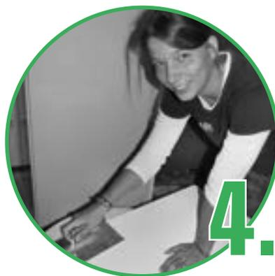
CaSi-Systems Wohnklimaplatten-Kleber 3in1 im angegebenen Mischungsverhältnis anrühren und mit einem Zahnpachtel vollflächig auf die Wand auftragen. Bei ebenen Untergründen kann der CaSi-Systems Wohnklimaplatten-Kleber 3in1 direkt auf die zu verarbeitenden Wohnklimaplatten aufgetragen werden.
