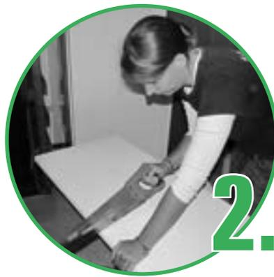
Die gewünschten Abmessungen anzeichnen und die CaSi-Systems Wohnklimaplatte Premium mit einer handelsüblichen Säge zurechtschneiden. Geeignete Staubschutzmassnahmen sind zu treffen.
