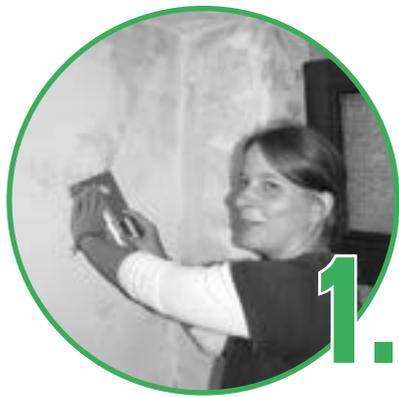
Restloses Entfernen alter Beläge wie z.B. Tapeten, Gipskartonplatten, Gipsputz, Farb- und Isolierschichten. Der Untergrund muss sauber und tragfähig sein. Bei Bedarf CaSi-Systems Schimmel-EX aufsprühen und Schimmel entfernen. Bitte bei grösserem Schimmel befall Schutzkleidung tragen (Atemschutzmaske, Handschuhe, Einmalanzug).
